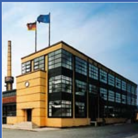
La planta Fagus, construída en 1911 por Walter Gropius
